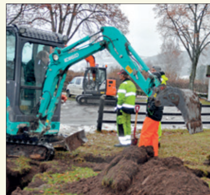
Flere grøfter mellom kapellet og kirkebygget er gravd for å føre fram vannrør og andre kabler.
