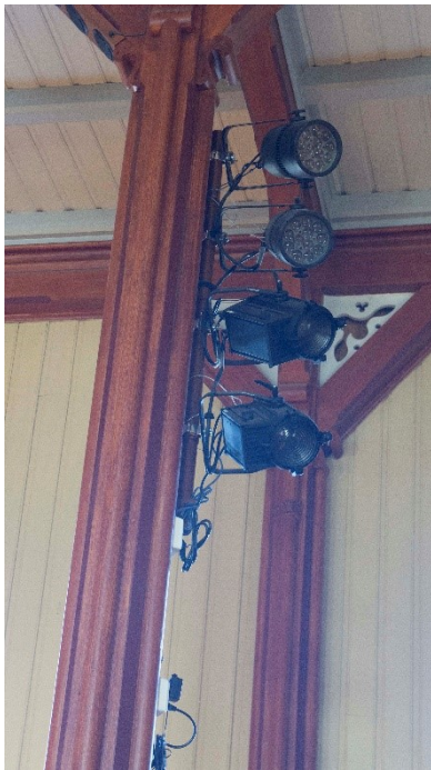
Lyskastere som ble montert i 2016. Lydanlegg viser en godt tilpasset visuell integrering av høyttalerne.
